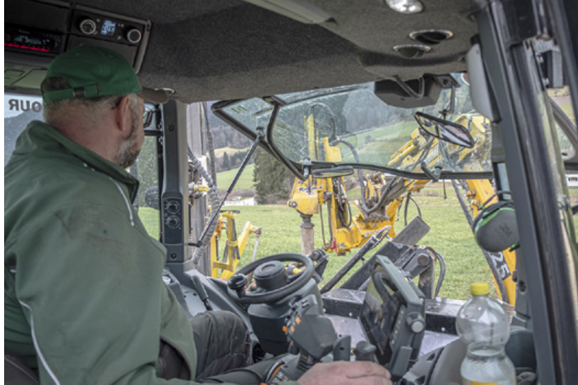
Travail en terrain vallonné avec foreuse et marteau.
